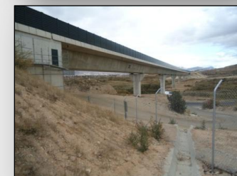
Výstavba nové tratě Alicante – Murcia (Španělsko)
